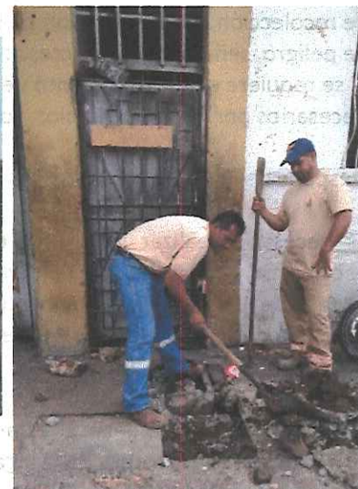
Clausura de fugas provocadas por habitantes de calle en predios ya demolidos y selladas por personal de EMCALI EICE, calle 13 A con carrera 12.
