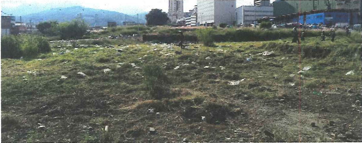
Poda de hierba y maleza en las manzanas ya demolidas en el "Proyecto Ciudad Paraíso"
