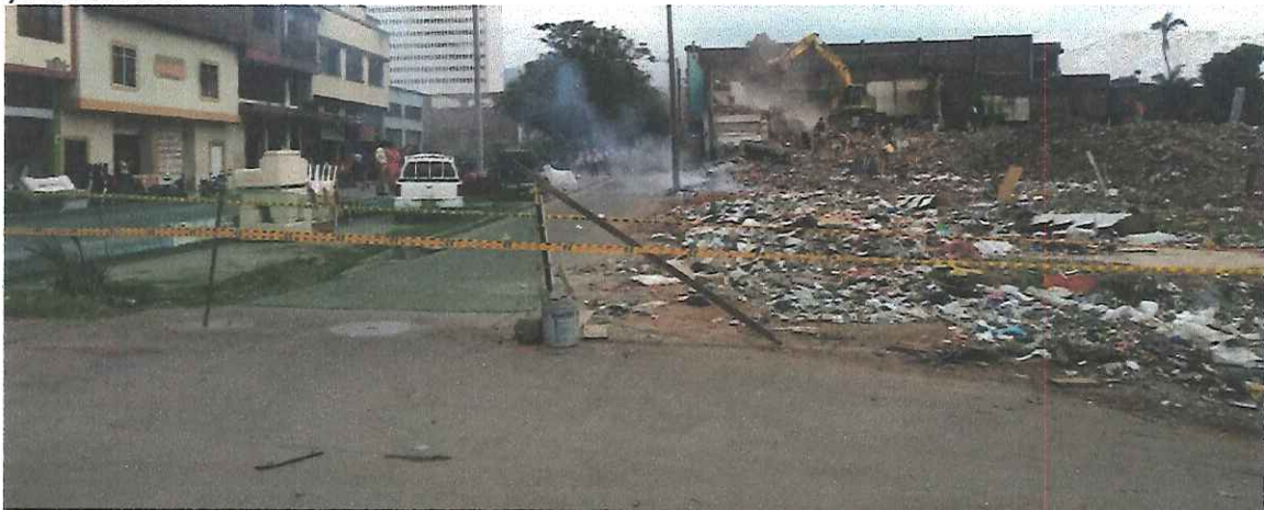
Medidas de seguridad y demolición en el "Proyecto Ciudad Paraíso"
